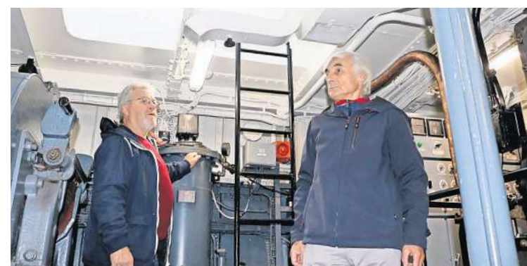
Wolfgang Mante und Josef Zirnsak (rechts) vom Förderverein sind mit der Qualität der Arbeiten im Maschinenraum der „Stralsund“ zufrieden. FOTO: TOM SCHRÖTER
