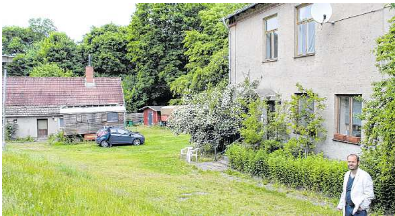
Das aus dem 19. Jahrhundert stammende, einst zum Gutshaus in Bauer gehörende Haus (r.) auf dem Bauerberg soll umgebaut werden.
